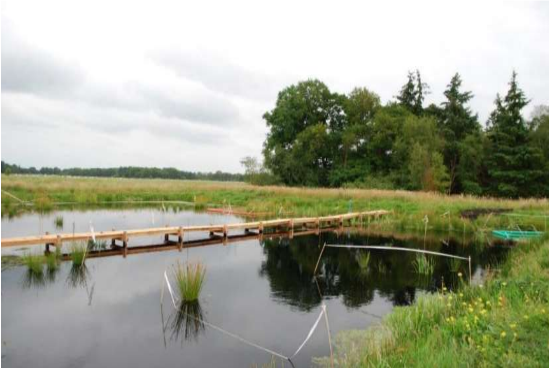
Abbildung 32: Wasserfilterbecken Quelle: ARSU (2021)
